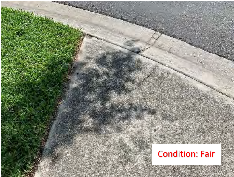
(265) Corner Crack
